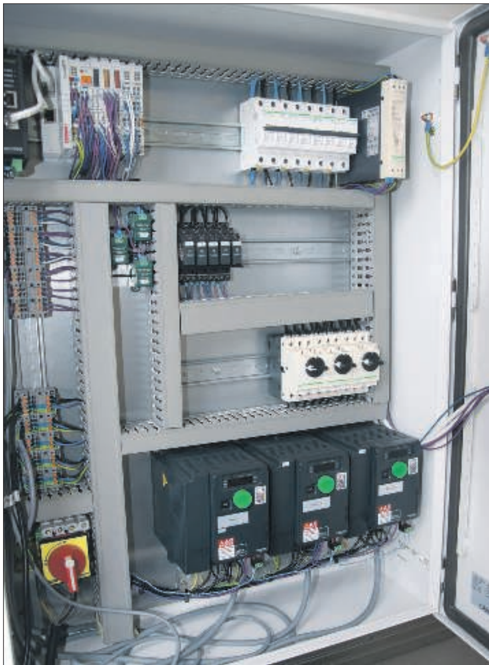
Carheal står over for at skulle levere sprøjtekabiner i tusindvis verden over til hurtig udbedring af laskader på biler. Styringen kommer fra Beckhoff og er IoT-baseret, så udnyttelsen af kabinerne og dokumentation af luftkvalitet optimeres.
