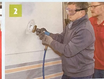
2 Der Riss und der umliegende Bereich werden geschliffen, bis das blanke Metall sichtbar ist.
