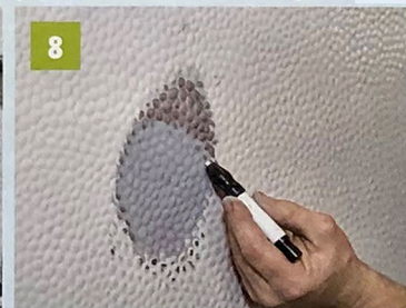
8 Sobald der Spritzspachtel trocken ist, wird mit einem Glasfaserstift gründlich geschliffen.
