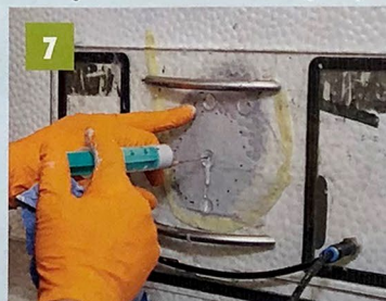
7 Die Negativmasse wird mit Spritzspachtel hinterspritzt. So wird der Hammerschlag sichtbar.
