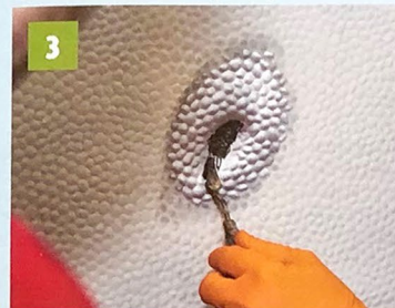
3 2K-Klebstoff versiegelt den Riss. So gelangt keine Nässe zwischen Alublech und Dämmung.
