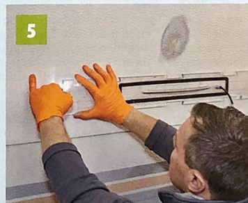
5 Da sich die Hammerschlagstruktur wiederholt, wird an einer gleichen Stelle eine Schablone angefertigt.
