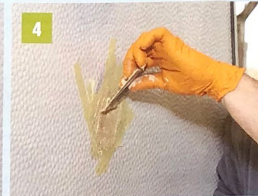
4 Nun wird die Vertiefung mit Spachtel aufgefüllt dann mit Schleifpapier eben geschliffen.
